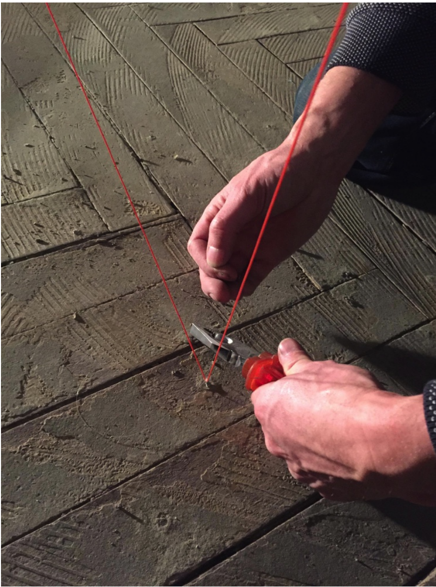
Die Installation der Elektroluminesz-Drähte.
